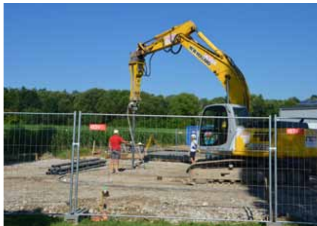
Pfahlgründung für die Fundamente
