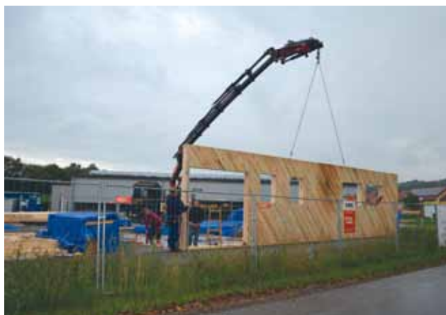
Die erste Wand steht!
