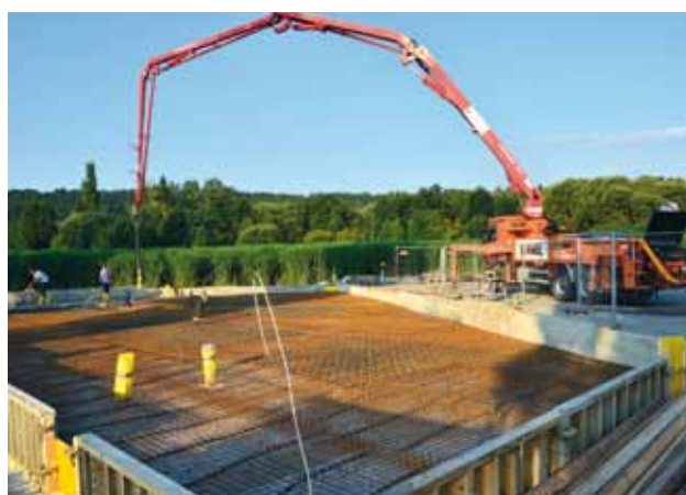
Betonieren der Bodenplatte
