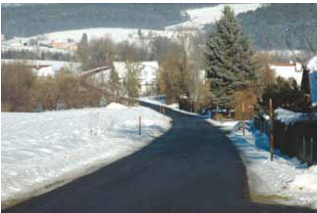
Die Eichbergstraße wurde von der Hochstraße bis zur Dombachbrücke neu asphaltiert.
