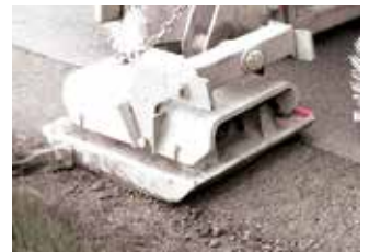
Verdichtung mit 70 Kilonewton
