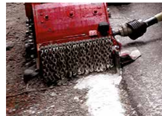
Stabilisierung mit Bindemittel
