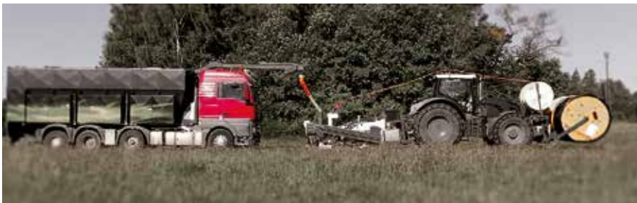
Micro-Rohrverlegung für ultraschnelles Internet
