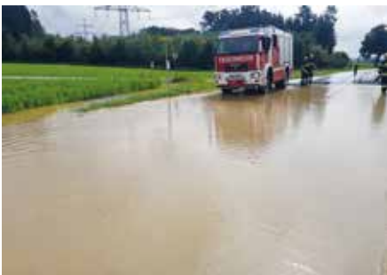
Die Landesstraße wurde an zwei Tagen überflutet.
